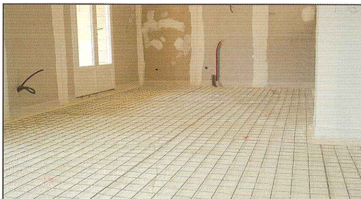
Pose de film plastique cadrillé
