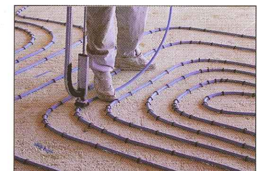
Mise en place des tubes chauffants
