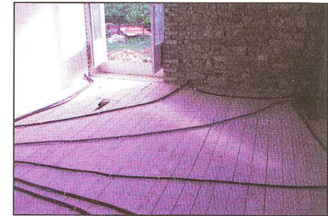
Rénovation plancher bois
